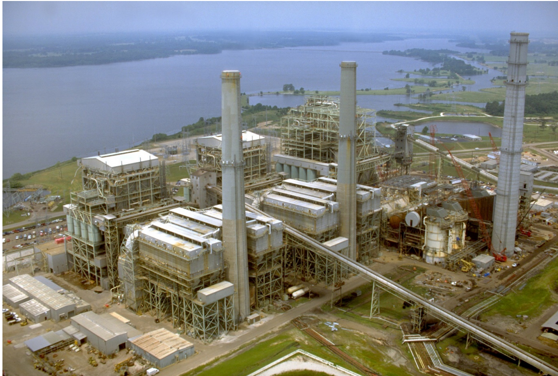
شکل (۱): تصویری از نیروگاه تولید برق از ذغال سنگ Monticello شرکت Luminant (زیرمجموعه Vistra Energy) در ایالت تگزاس آمریکا که طبق برنامه در اوایل سال ۲۰۱۸ میلادی تعطیل خواهد شد [۲].
